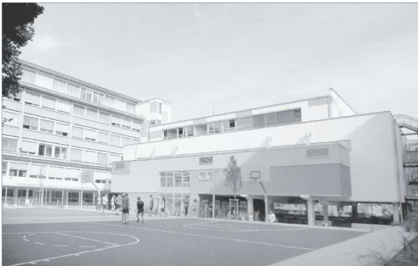
Die neue Turnhalle steht: Die neue Mensa für den Hochbegabtenzweig des Max-von-Laue-Gymnasiums wird darunter entstehen – gefördert aus dem Konjunkturpaket II. Insgesamt fließen bis Ende 2011 viele Millionen in die Koblenzer Schulen. ■ Foto: Hoppen
